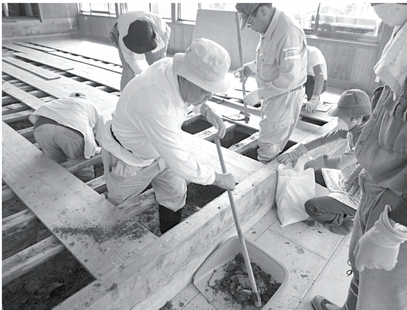
公民館の床下の泥出しの様子
