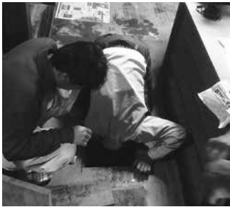
床下診断の様子
