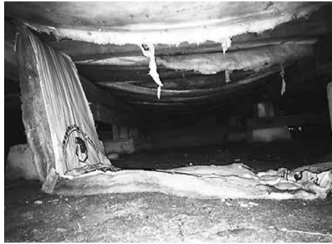
床下の断熱材が水を含み垂れ下がった状態
